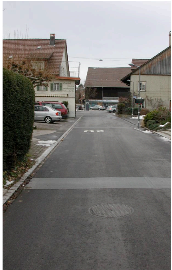
Mischflächenausbau im ganzen Bereich der Begegnungszone
